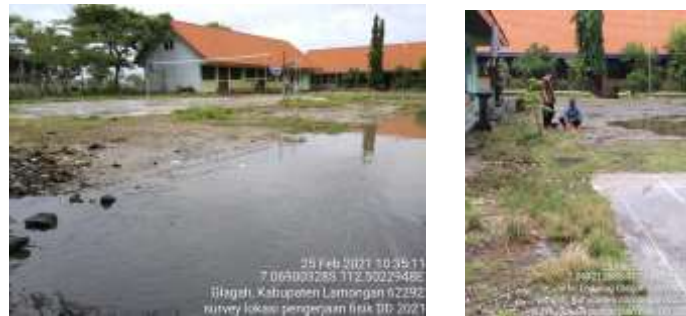
Gambar 1. Kondisi eksisting lapangan voli
